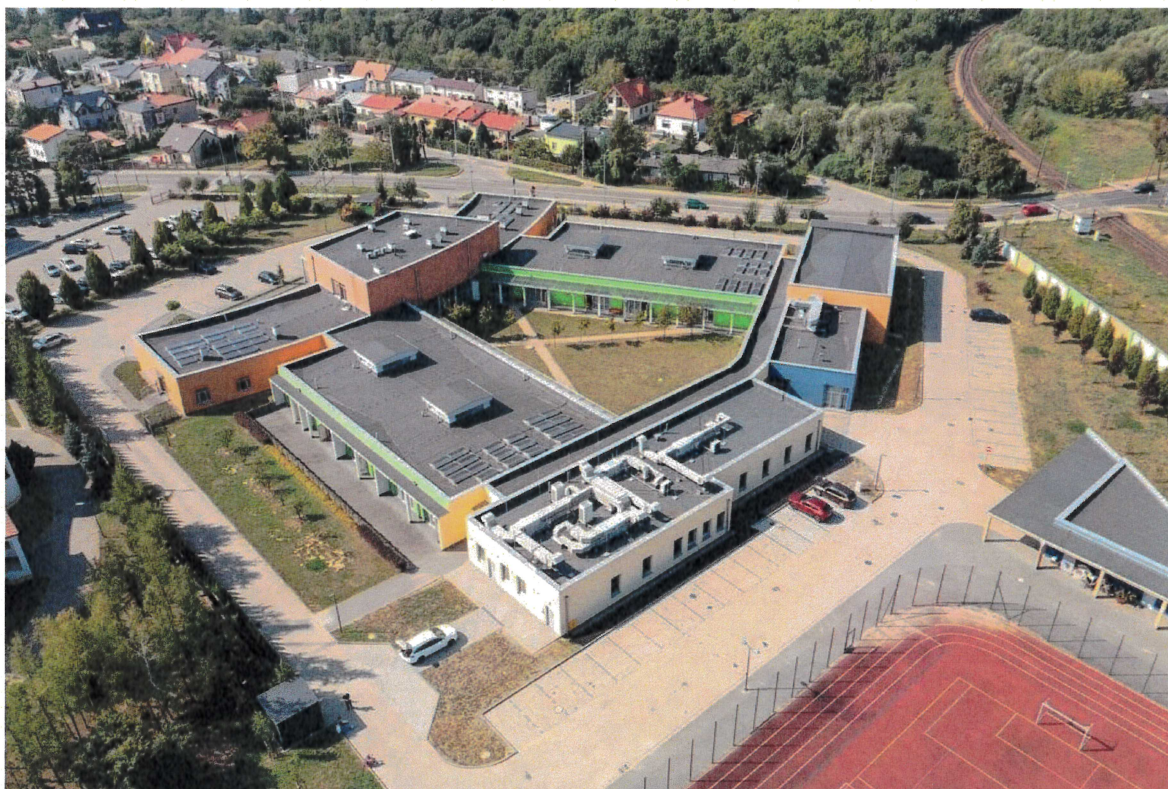
Widok na dobudowaną część z góry
