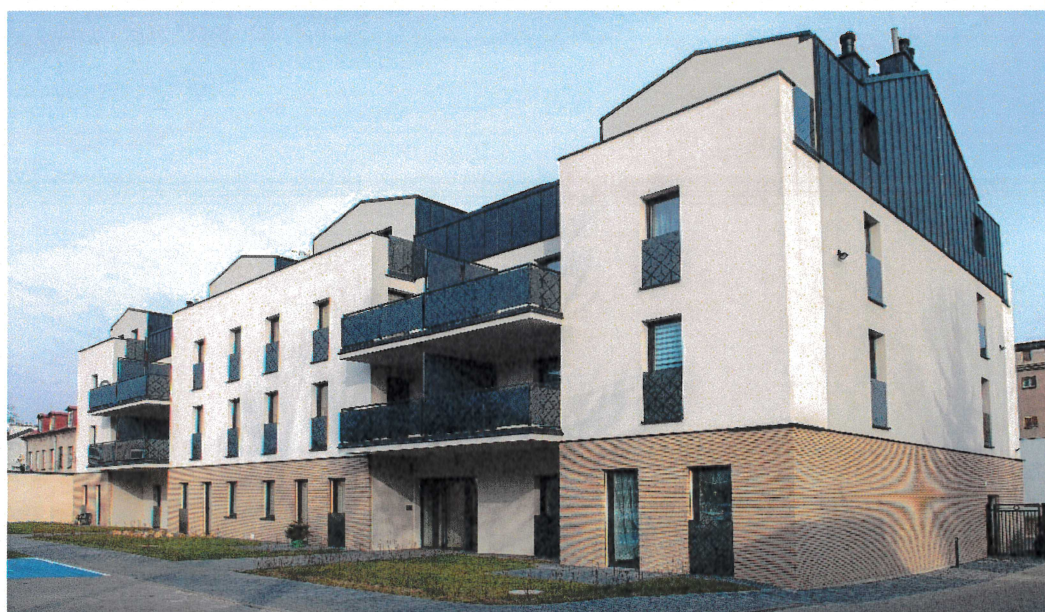
Elewacja południowa i północna budynku
