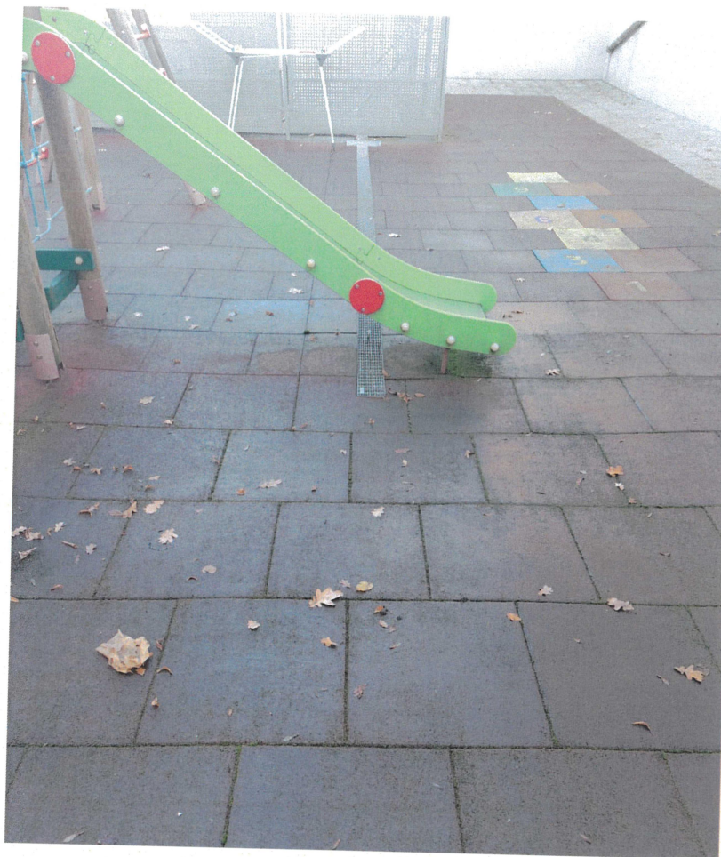
Stan istniejący nawierzchni tarasu
