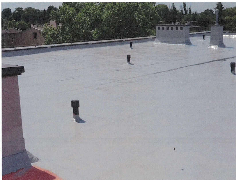
Zdjęcie poglądowe – nawierzchnia dachu z membrany
