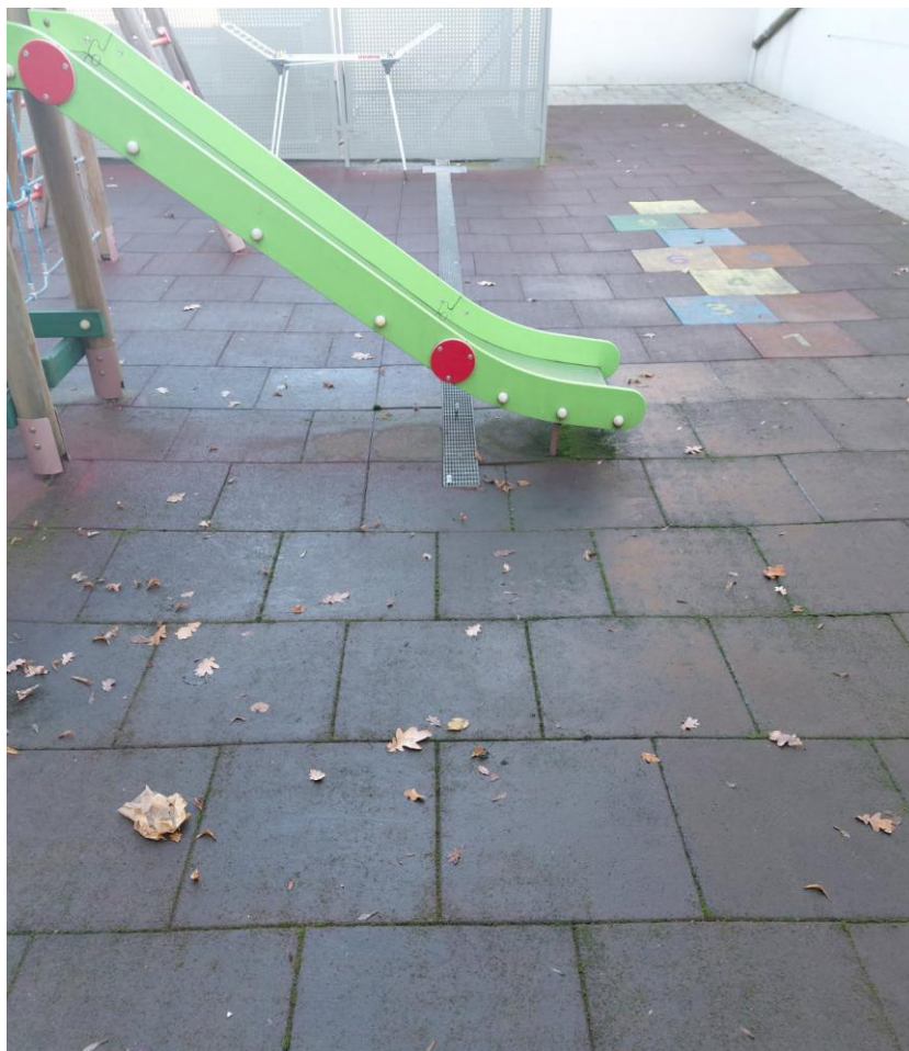
Stan istniejący nawierzchni tarasu
