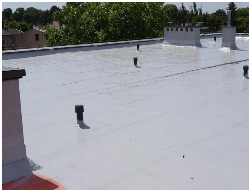
Zdjęcie poglądowe – nawierzchnia dachu z membrany
