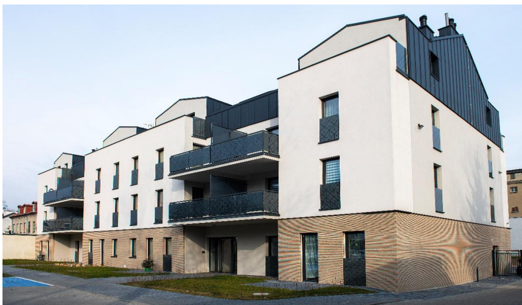
Elewacja południowa i północna budynku
