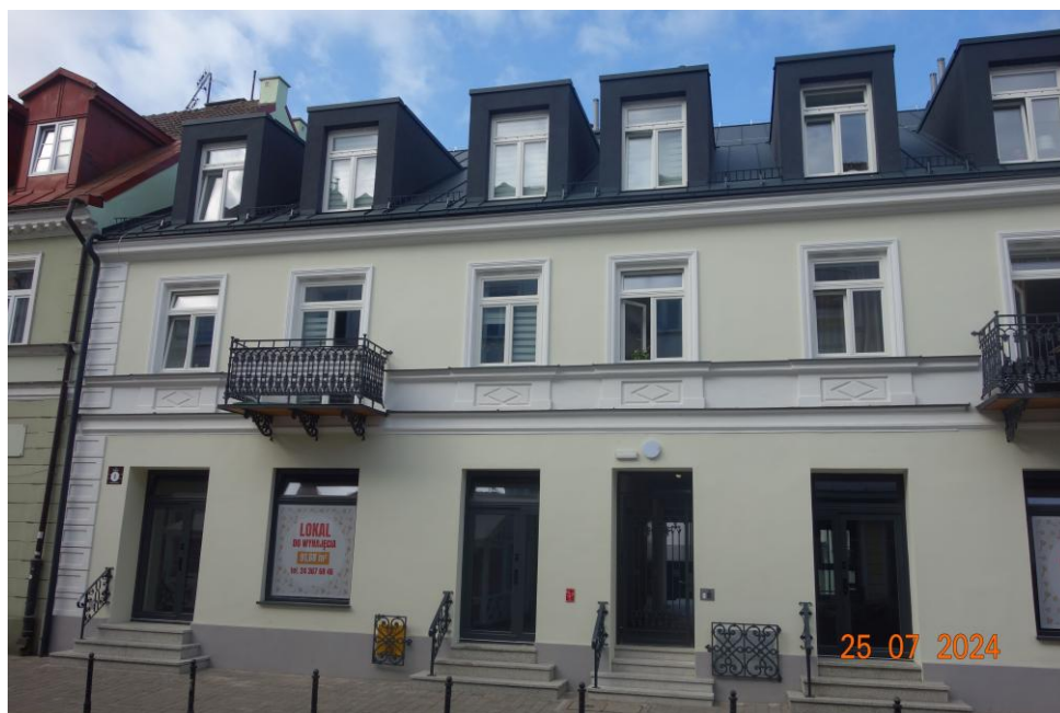
Elewacja frontowa budynku głównego od ul. Grodzkiej po remoncie.
