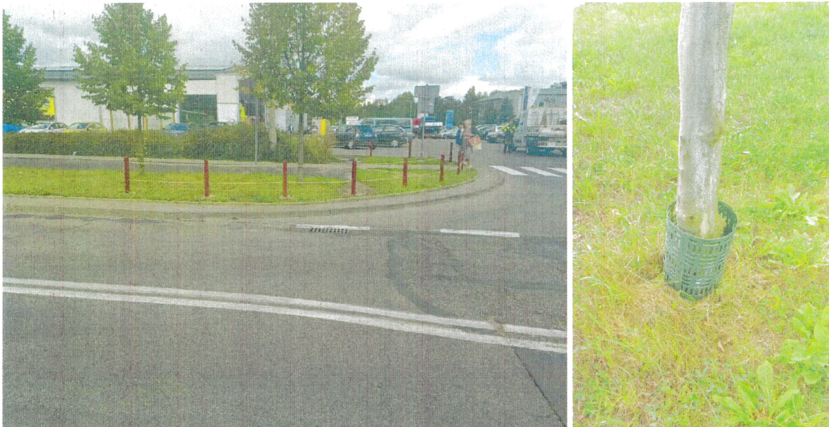
Wygradzenie słupkami ul. Drętkiewicza oraz zabezpieczenie drzew osłonkami
