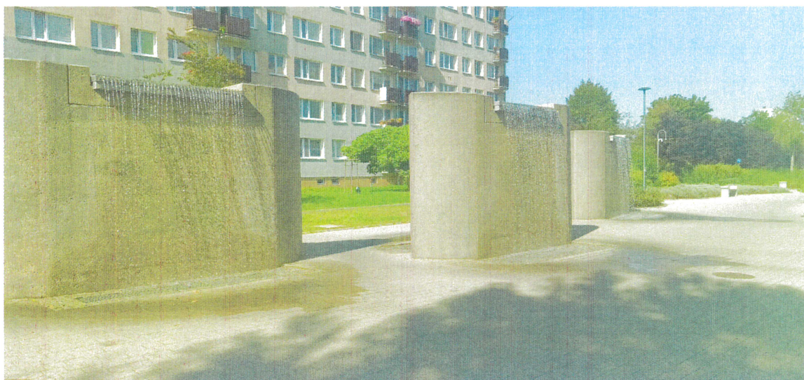
kaskady na al. Roguckiego – przed i po czyszczeniu:
