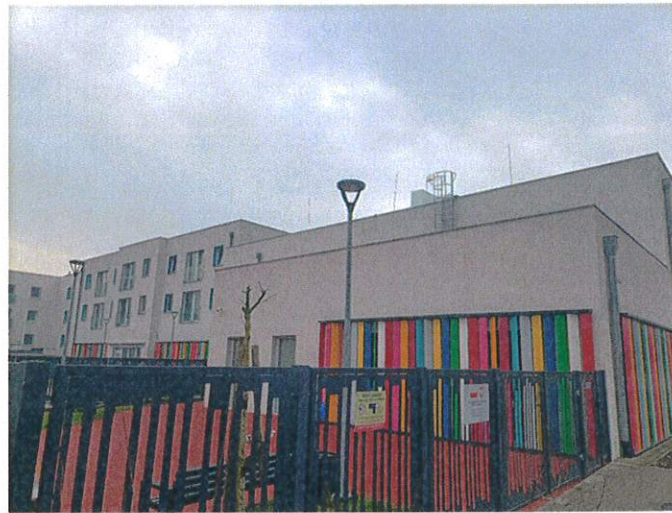
Etap I – Budynek A
